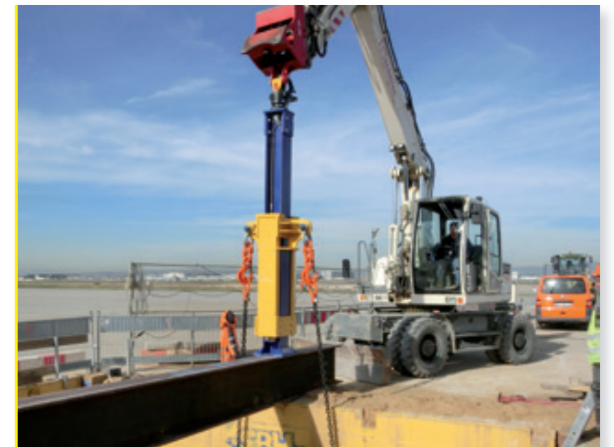
Bei ungünstigem Untergrund kann zur Lastableitung ein Träger benutzt werden. Bei Verbauplatten anderer Hersteller ist aufgrund der Kopfkonstruktion immer mit einem Träger zu arbeiten.
