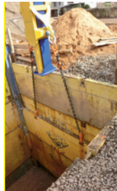
Ziehen der Grund- und Aufstockplatte mit dem Hydralifter in einem Arbeitsgang.
