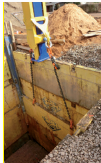
Aufsetzen des Hydralifters auf die Platte.
